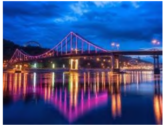
Пішохідний міст. Київ
